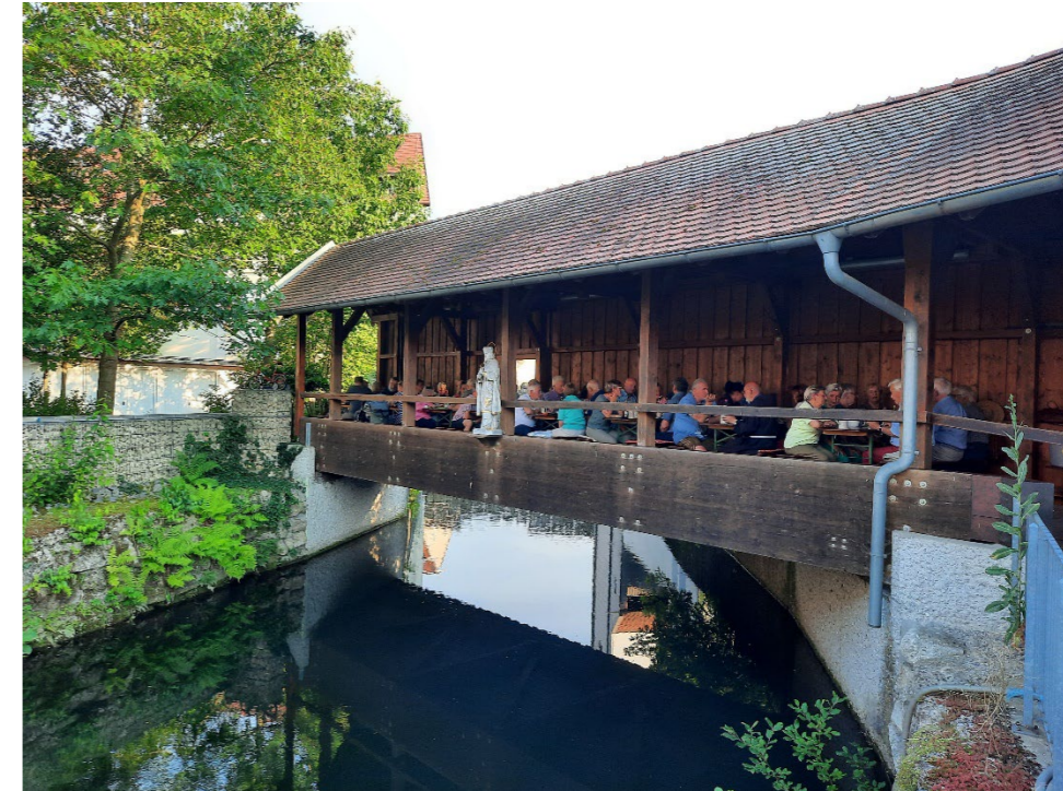
Die Brücke über den Mörbach
